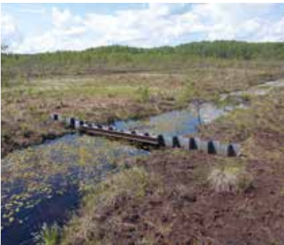
Figure 147. Plastic pile sheet dam. Photo: J. Sendžikaitė.
