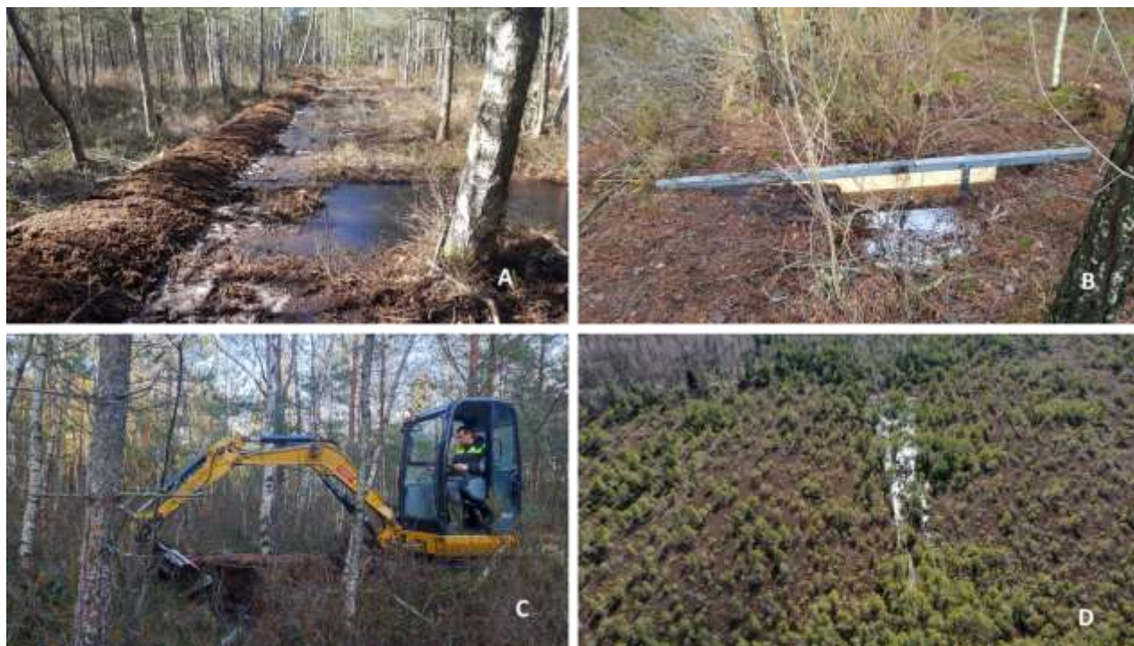
24 pav. Hidrologinio režimo atkūrimo priemonės Aukštumaos pelkės pietvakarinėje dalyje, 2021 m. Durpinis pylimas su geomembrana (A), užtvankos iš OSB plokštės (B), durpinių užtūrų įrengimas (C), po pavasarinio polaidžio pakilęs vandens lygis (D).
