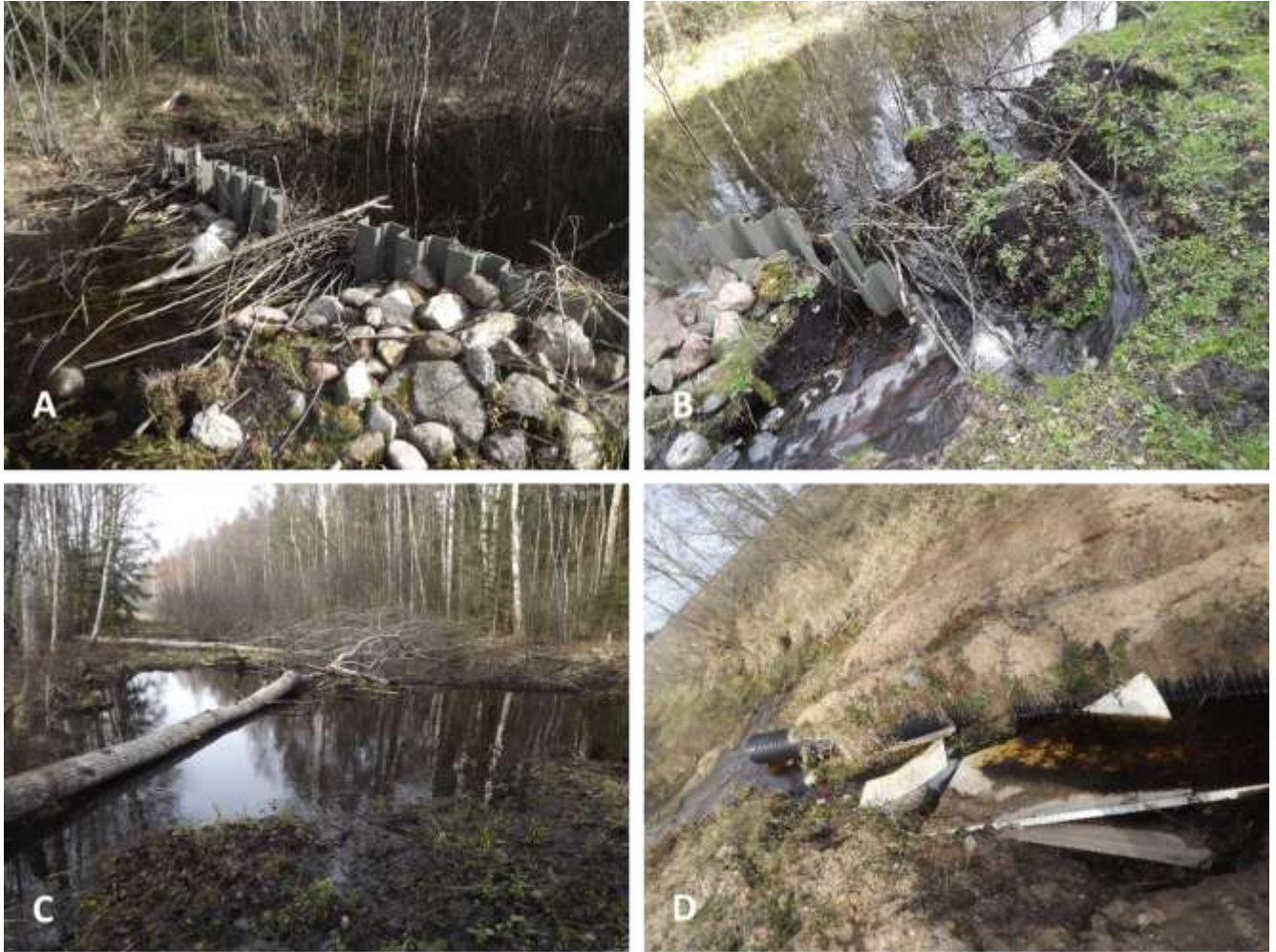
53 pav. Hidrologinio režimo atkūrimo priemonės Bulėnų pelkėje. Surenkamajame griovyje pakilęs vanduo (A, C) ir plastikinių bei kompleksinių užtvankų pažaidos (B, D)
