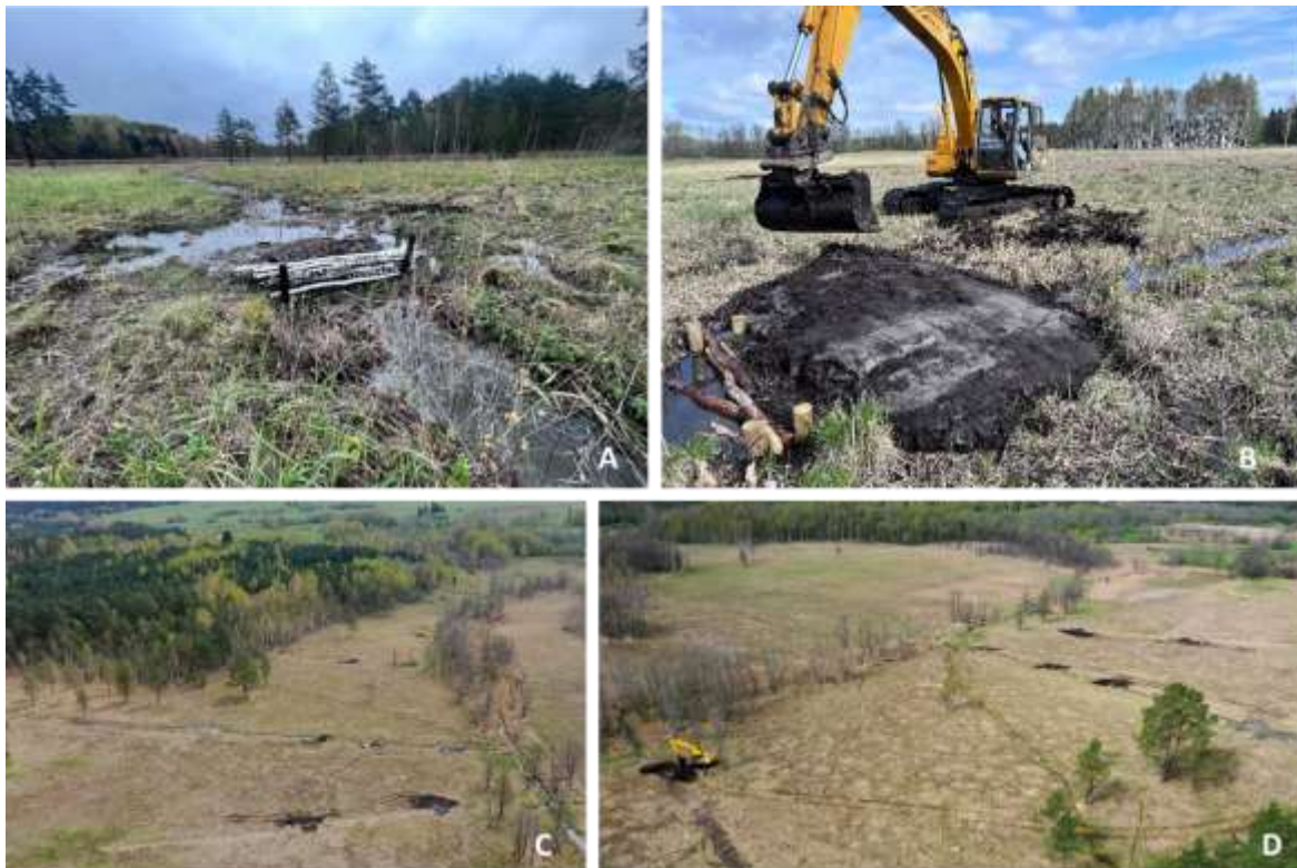
36 pav. Durpinių užtvankų įrengimo darbai Svirplinės pelkėje, 2022–2023 m.
