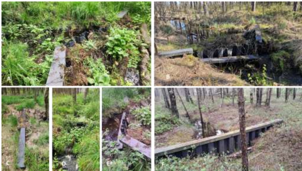
45 pav. Deformuotų užtvankų iš plastikinių spraustasielių pavyzdžiai ant ištiesinto Duburo upelio (A–E) bei vandens nuotėkj sulaikančios užtvankos pietrytinėje pelkės dalyje pavyzdys (F).
