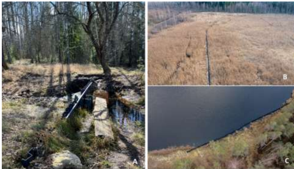
33 pav. Plastikinių sprasutasienių užtvaros stabdančios vandens nuotėkjį iš sausinimo griovių bei Kulio ir Ešerinio ežerų (B, C).
