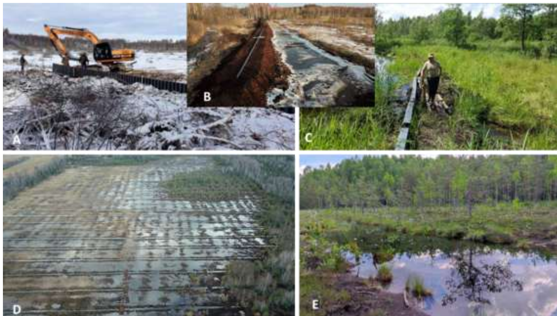
50 pav. Atlikti hidrologinio režimo atkūrimo darbai sustabdė vandens nuotėkį iš pelkės (A, B, D, E). Pelkės pakraštyje įrengtame pylime pastebėtos pažaidos (C).
