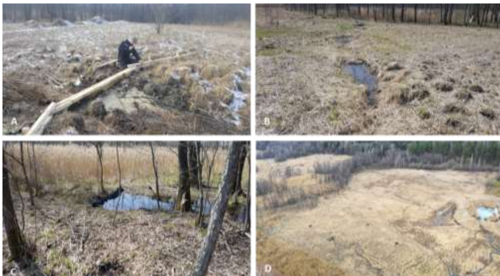
39 pav. Tartoko pelkės hidrologinio režimo atkūrimas. Griovių blokavimas medinėmis MDF plokštėmis (A, B) ir plastikinėmis sprastasieneėmis (C), vaizdas iš viršaus po visų gamtotvarkos darbų įgyvendinimo (D).
