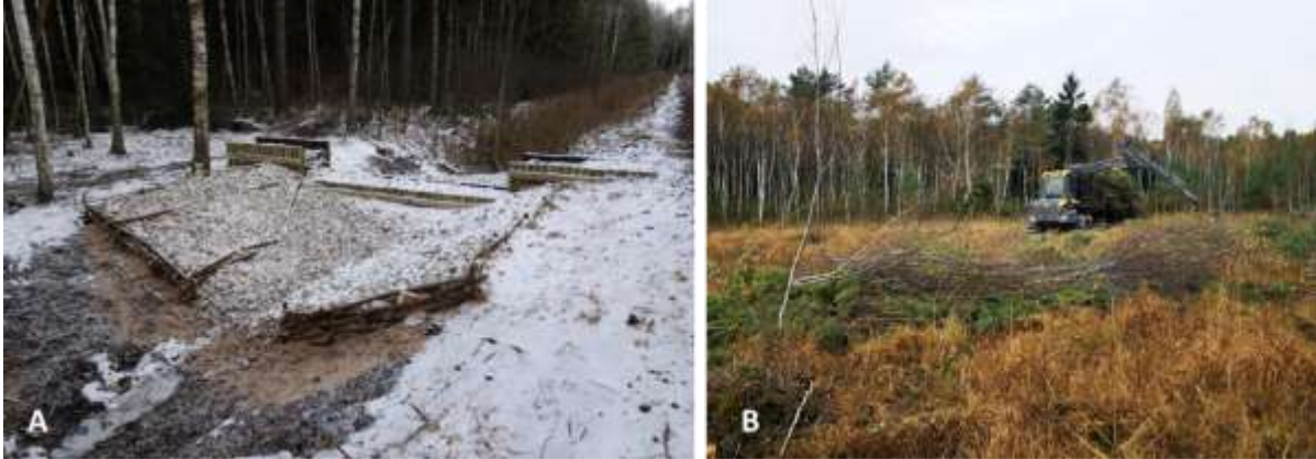
57 pav. Hidrologinio režimo atkūrimo darbai įrengiant kompleksinę užtvanką ant surenkamojo griovio (A) bei sumedėjusios augalijos šalinimo darbai (B) Pašilių pelkėje.
