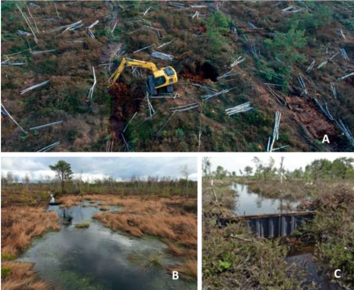
21 pav. Hidrologinio režimo atkūrimo darbai Aukštumalos pelkėje, 2015–2016 m. Durpinės (A) ir plastikinių spraustastienių (B, C) užtvankos.
