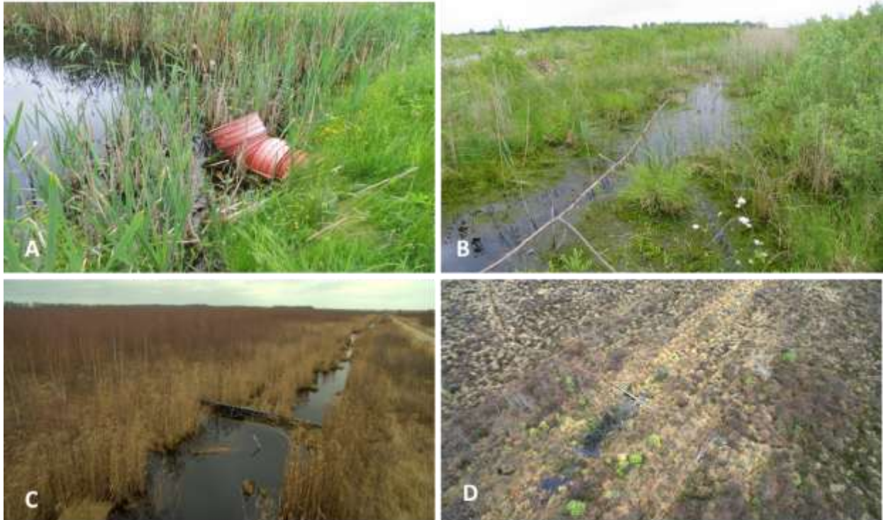
56 pav. Amalvos pelkėje įrengtos pertvaros iš plastikinių sprastasielių (B-D) bei kompleksinė užtvanka su vandens pertekliaus nutekėjimo vamzdžiu
